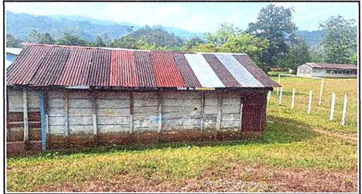
Foto 2: Aula: Cambio de techo, pared, ventanas y balcones.
