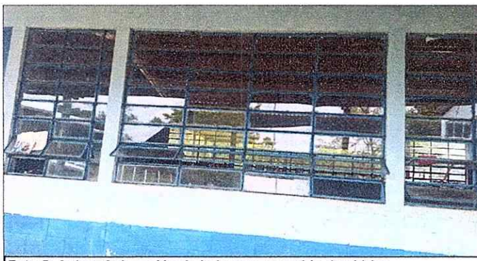
Foto 5: Aulas: Colocación de balcones y cambio de vidrios.
