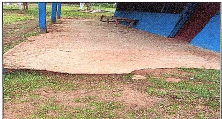
Foto 4: Remozamiento en el patio de cocina.
